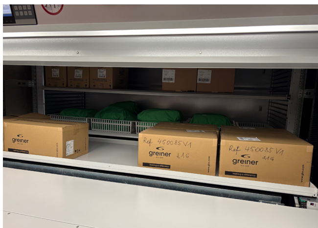
Kardexi vertikaalladu ühendab haigla kõiki korruseid, olles ühekorraga nii lift, ladu kui jaotuspunkt
